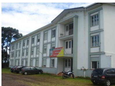
Vista geral do prédio onde é a sede da EFASC, junto ao Seminário São João Batista, em Linha Santa Cruz.
