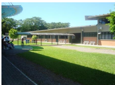
Bloco 51 da Engenharia Agrícola, onde ocorrem as aulas e o uso de diversos laboratórios da área agrícola.
